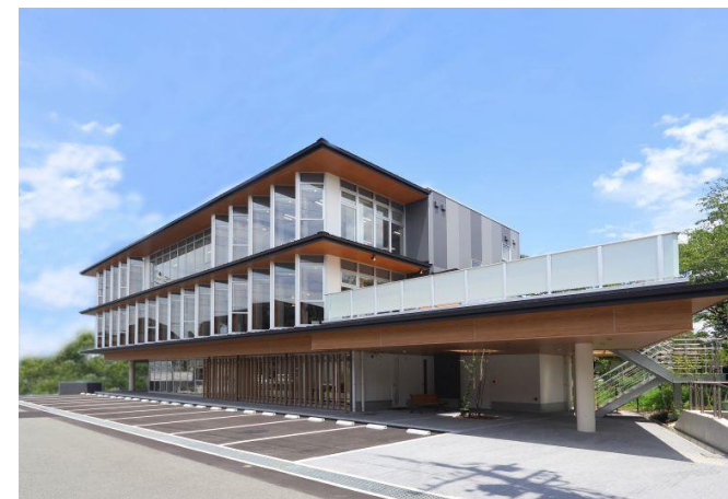
新築の西日本支社（姫路）
